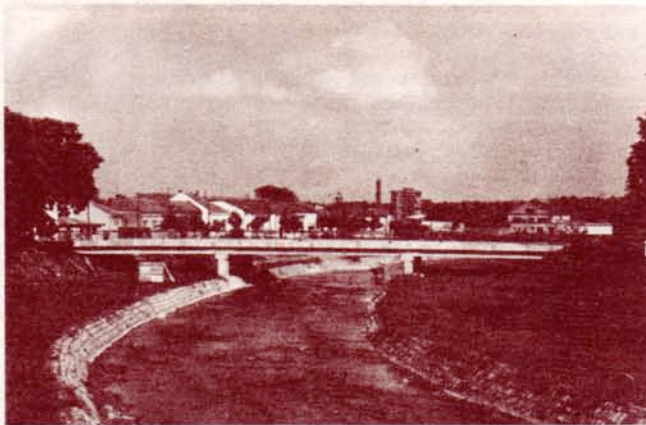
Нови колубарски мост
